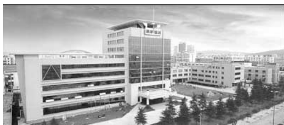
图 5 江苏赛摩集团建在科技园的大楼
