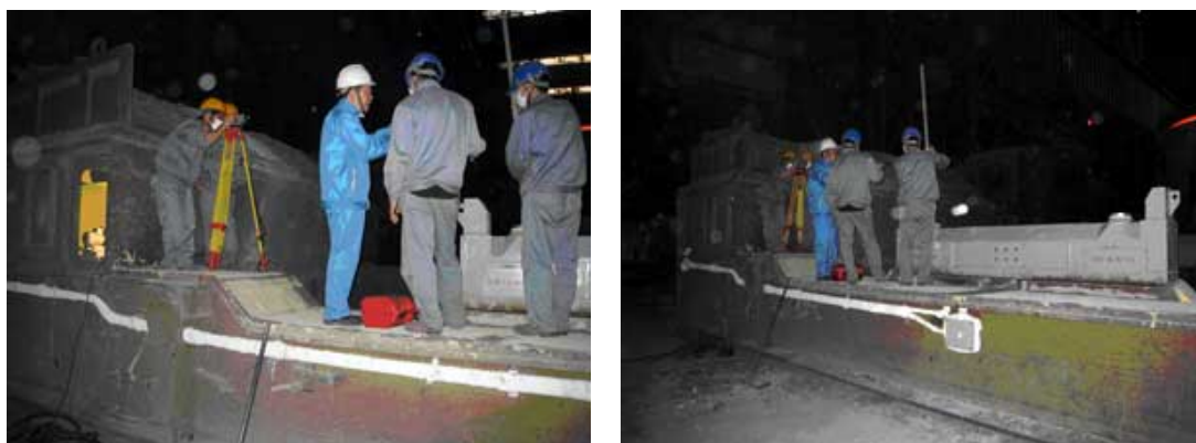
图 7 HSB-A-450t 大型转炉出钢车称量装置安装现场
