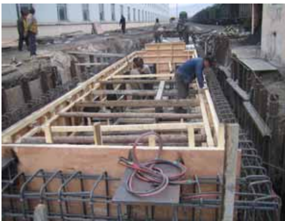
宽轨轨道衡基础施工照片
