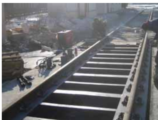
秤梁安装时照片
