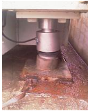
图 7 柱式传感器安装图
