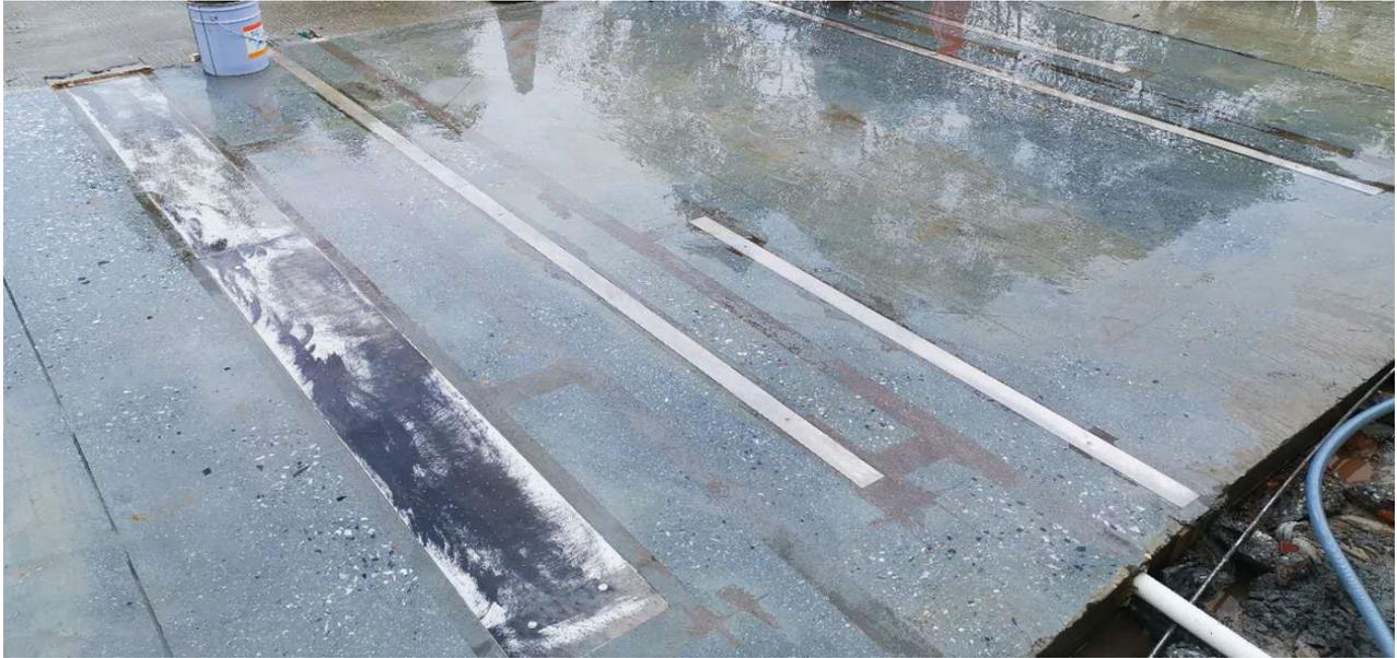
图4 窄条式和窄板式称重单元安装现场
