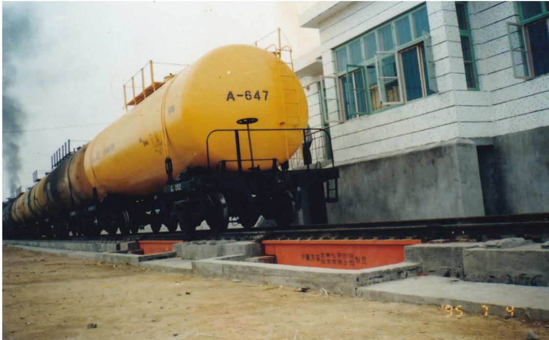
图12 轨道衡基础外观
