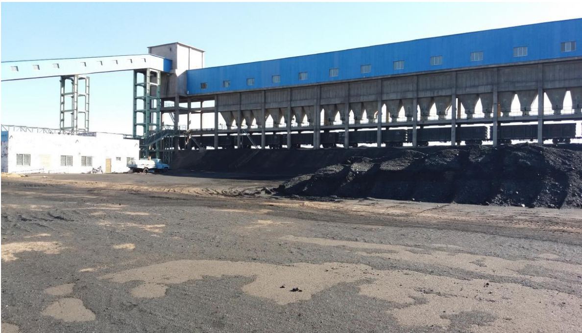
图1 项目现场输煤皮带及筒仓
