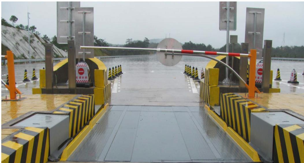
图4 轴组式动态汽车衡
