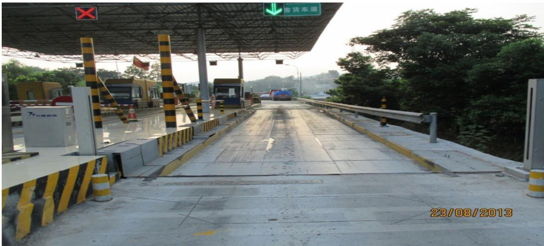
图2 整车式动态汽车衡
