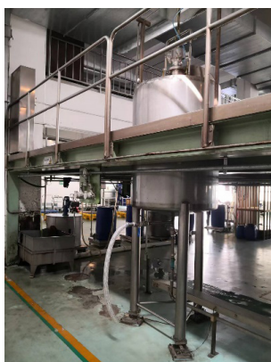
图1 罐体的三个支腿安装于三个称重传感器上
